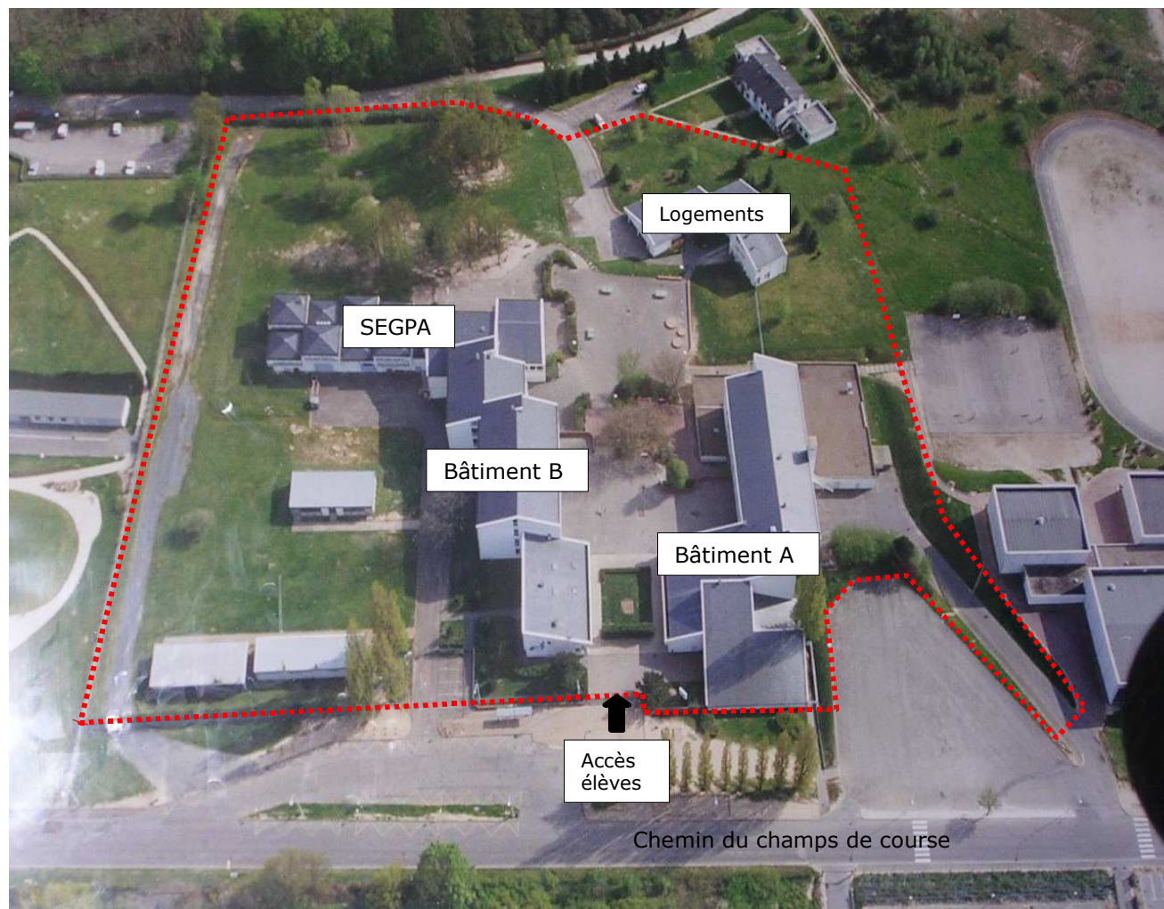
ETAT EXISTANT : VUE AERIENNE DU COLLEGE
