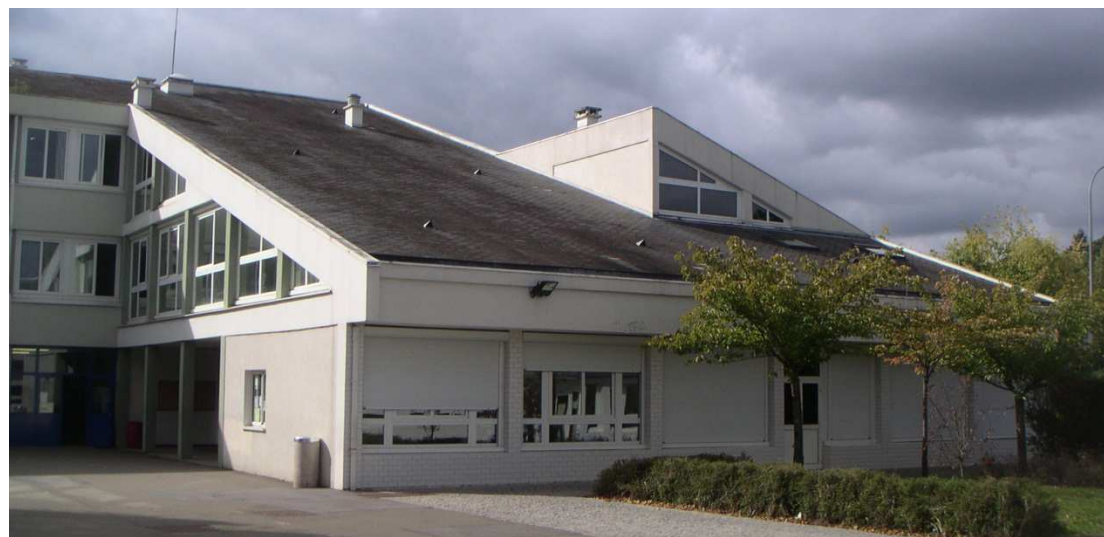
BAT. A : VUE DEPUIS LA COUR DU COLLEGE
